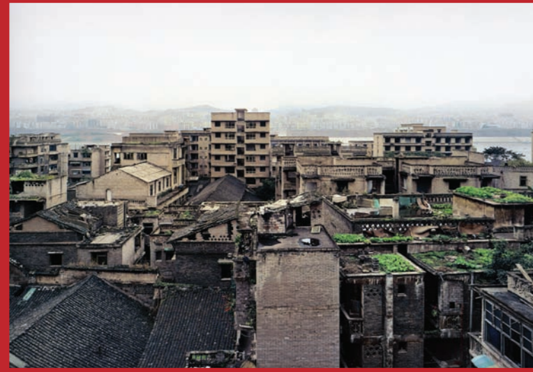
Fengdu, Chongqing Municipality
